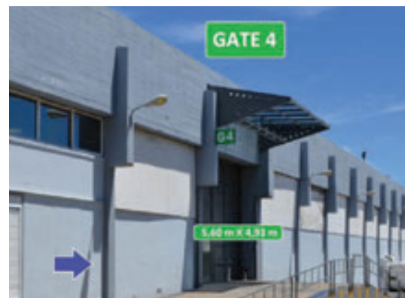
Η πύλη εισόδου ελαφρών επαγγελματικών αυτοκινήτων και άλλων εκθεμάτων. Υπάρχουν επίσης πύλες εισόδου εμπορευμάτων με ράμπες για φορτηγά καθώς και ανελκυστήρες εμπορευμάτων.
